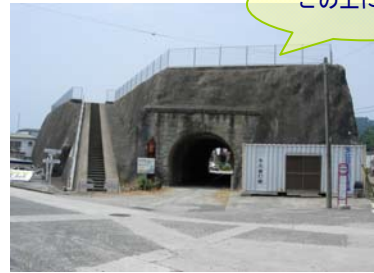
③ 避難マウンド（沼津市多比） （県道の旧トンネル上を避難用地に活用）
