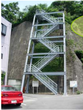
④ 避難階段（沼津市多比） （急傾斜地崩壊対策法面に階段を設置）
