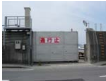
② 志下6号陸閘（沼津市志下）
