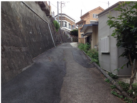
避難路の例(手摺り設置)
