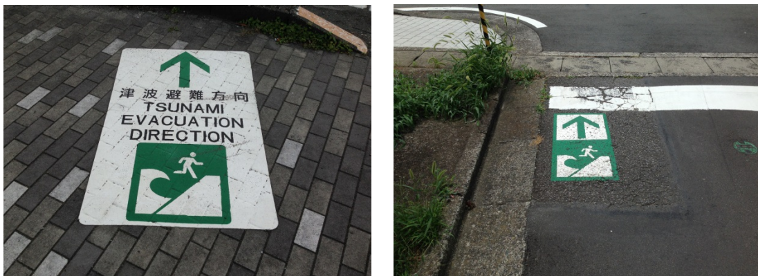
避難方向路面標示の例
