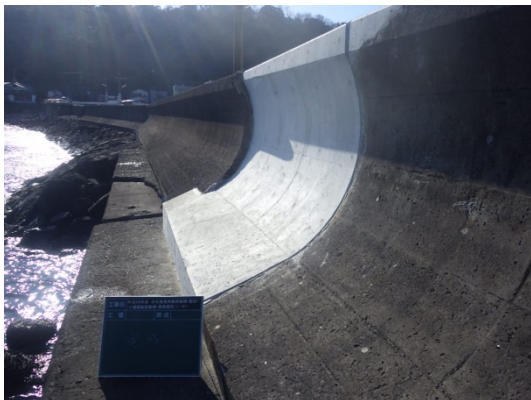
川奈防波堤（クラック補修済み）
