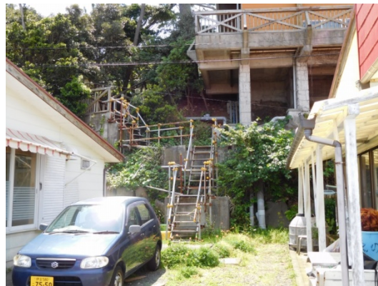
既設階段を改修・再整備
