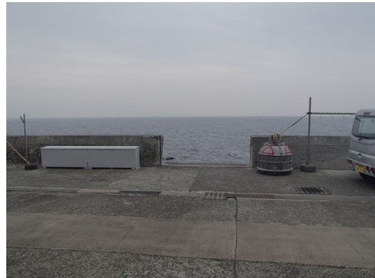
開口部左の箱に角落としが格納されている
