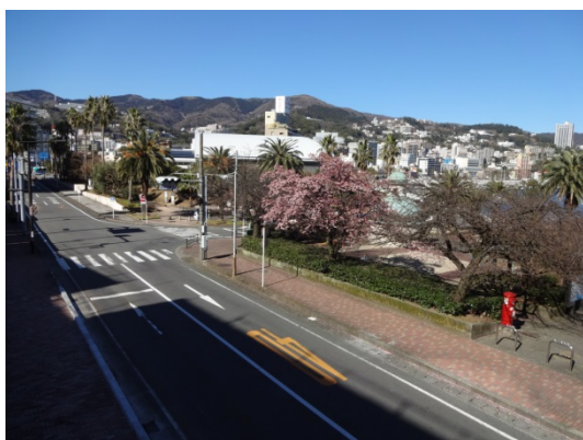
渚4工区南側現況
