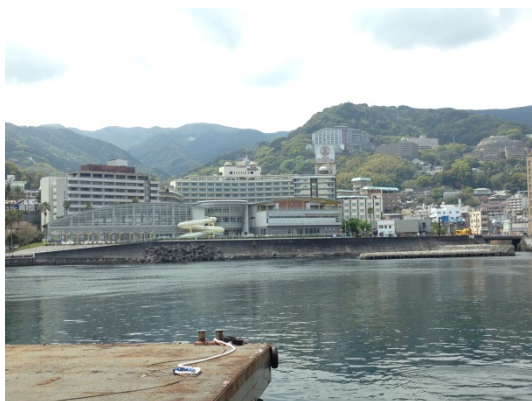
渚4工区（平成29年4月）
