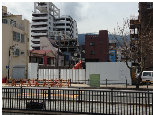
建築中のビル（津波避難ビル指定見込）（平成 29 年 4 月）
