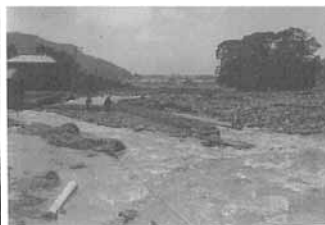
部田神社付近の被災状況 (昭和13年大洪水)
