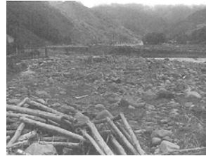
大川左岸の破壊された堤防(平戸橋下流:昭和13年大洪水)
