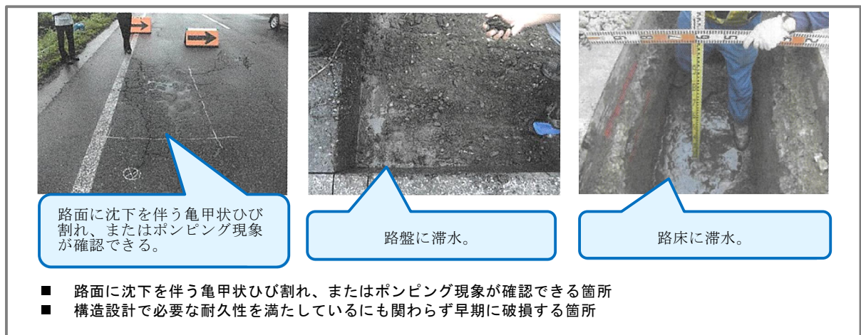
図解-3.4 開削が必要な箇所の例
