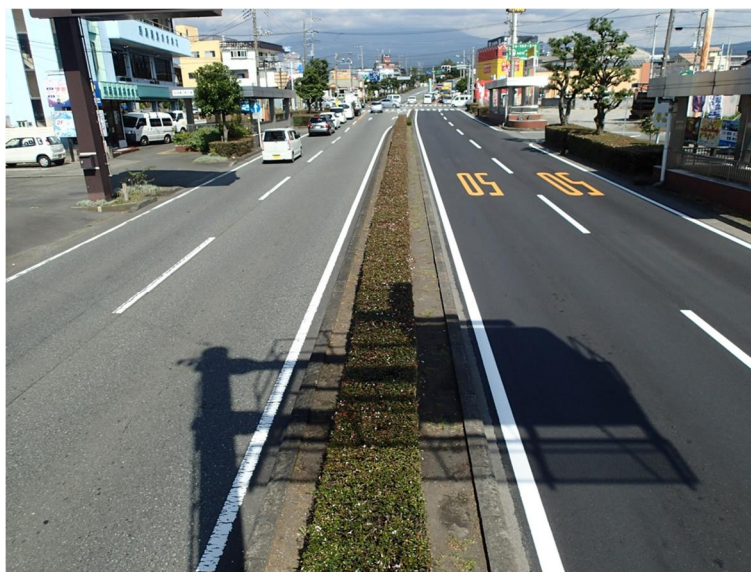
写真解-3.1 片側2車線道路における異なる時期の修繕例
