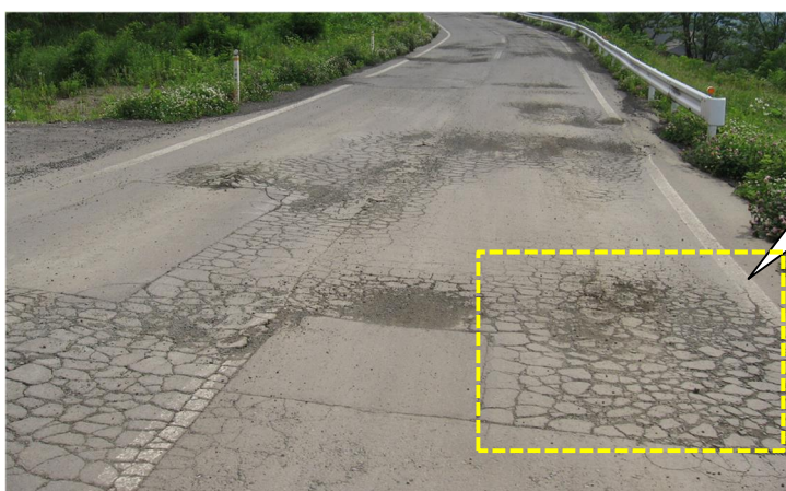
付写真-1.1 亀甲状ひび割れの例
