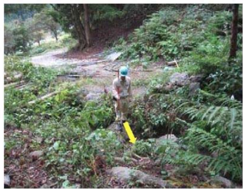
写真④ 別角度からみた発生箇所の状況
