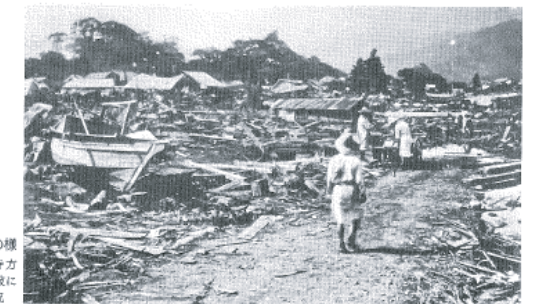
図14-8 現静海町の様子 仏光寺方向を見た津波による被害状況
