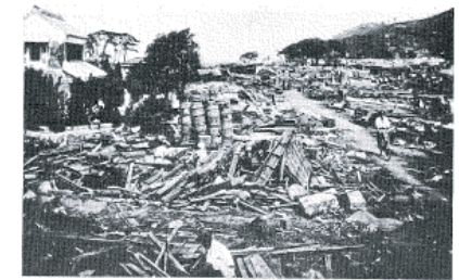
図14-7 秋葉美の津波被災状況
