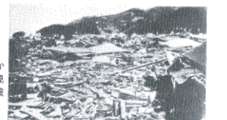
図14-16 環和田1丁目から新井方向を見た津波による被災状況
