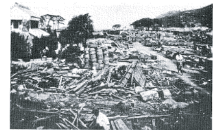
図14-7 玖須美の津波被災状況
