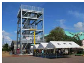
津波避難施設
