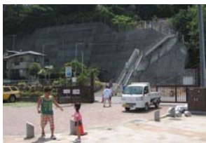
急傾斜施設に設置した津波緊急避難用階段
