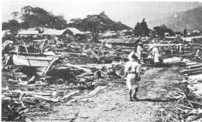
図14-8 現静海町の様子 仏光寺方向を見た津波による被害状況
