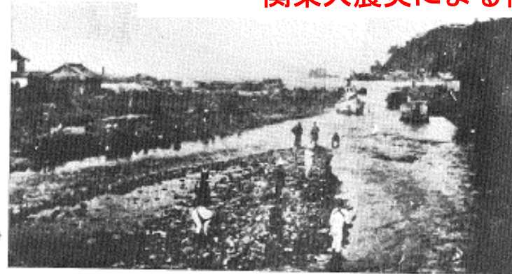
図14-13 伊東大川河口付近の様子
