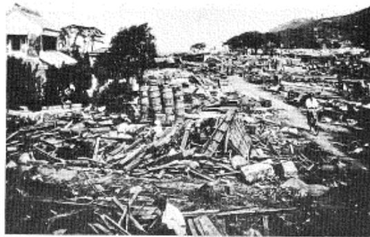
図14-7 玖須美の津波被災状況
