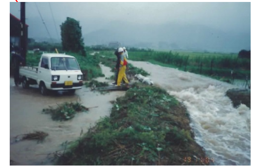
H3.9被害状況(梅田川(半尻川))
