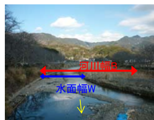
3.800k 建久寺橋（南郷橋）上流
