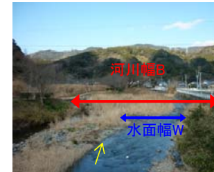
5.400k しろかに橋下流
