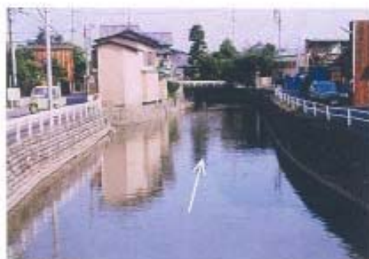
石脇川（下流工区，国道150号すぐ下流）
