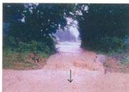
朝比奈川溢水状況I川合流点上流(H2. 8)
