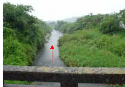
図 2-13 しみずばし 清水橋直下流の状況(4.9km 付近)
