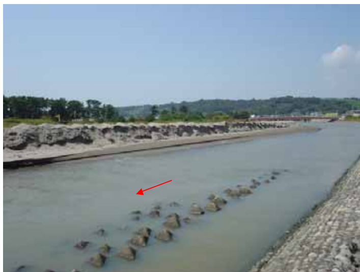
図 2-17 河口部の浚渫による河道の維持
