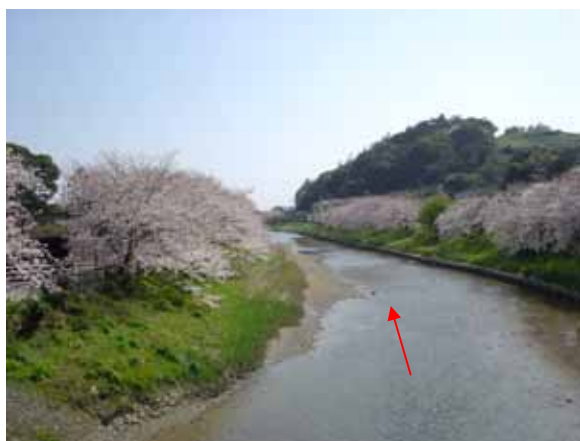
図 2-6 勝間田川堤の状況(2.0km 付近)
