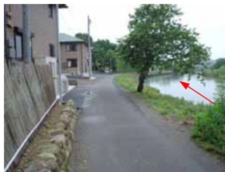
図 4-3 1.2km 付近左岸側の現状
