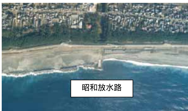
図 2.9 昭和放水路下手側の侵食状況
