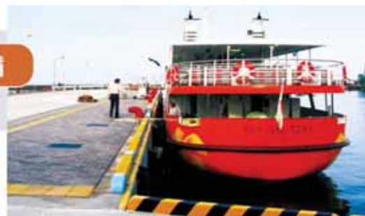
伊東港観光栈橋H21年度完成
