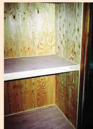
押入れ内の補強 押入れの壁を筋かいと構造用合板で補強しました。押入れ内は塗装や壁紙の工事が不要なので工事費用を抑えることができます。
