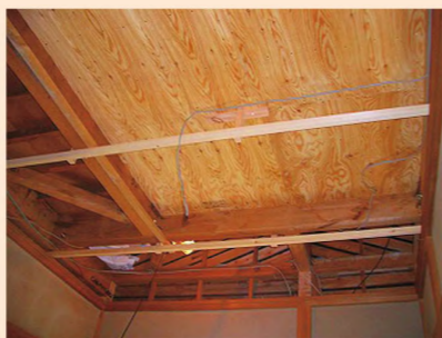
床剛性の確保 2階の床組みを補強することによって、1階に新設した筋かいなどの耐力壁の補強効果が高まります。
