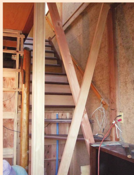
1階玄関ホールに新設した筋かい
