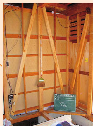
1階に新設した筋かい
