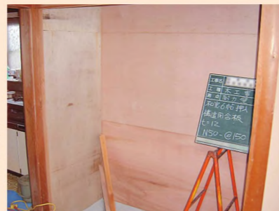
構造用合板による補強 筋かいと構造用合板で補強した箇所です。筋かいだけの補強よりも強い耐力壁にすることができます。
