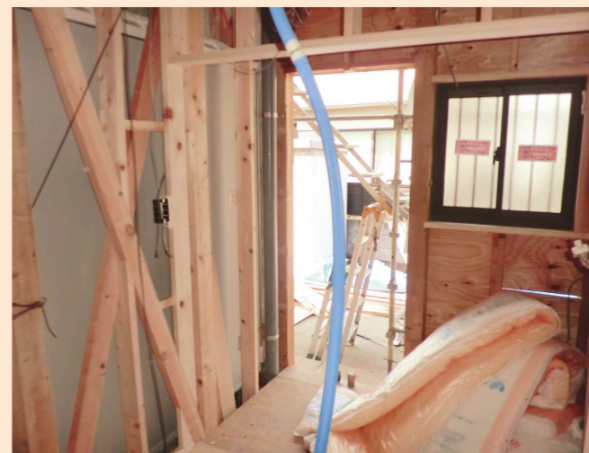
便所、浴室間に新設した筋かい
