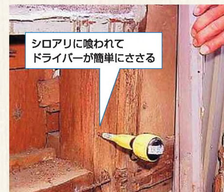
防蟻材を塗布した柱材に交換
