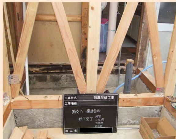
便所、浴室間に新設した筋かい
