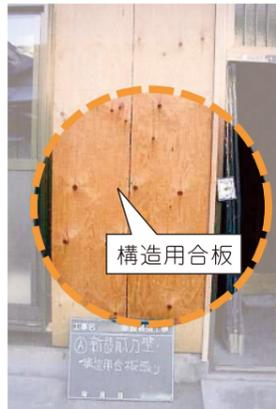
壁に構造用合板(強度の強い板材)を貼り、横揺れに強い壁に補強します。長さ50mmの釘を15cm間隔に土台、柱、間柱、梁(胴差)に打ち付けます。
