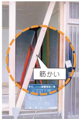
筋かい(斜めに設置した木材)により、横揺れに強い壁に補強します。各部材の接合部は専用の金物で補強します。
