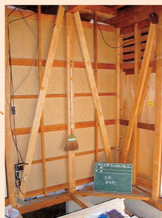
1階に新設した筋かい
