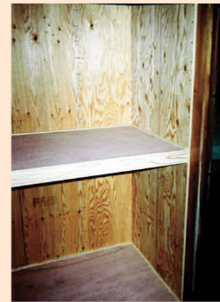
押し入れ内の補強 押し入れの壁を筋かいと構造用合板で補強しました。押し入れ内は塗装や壁紙の工事が不要なので工事費用を抑えることができます。
