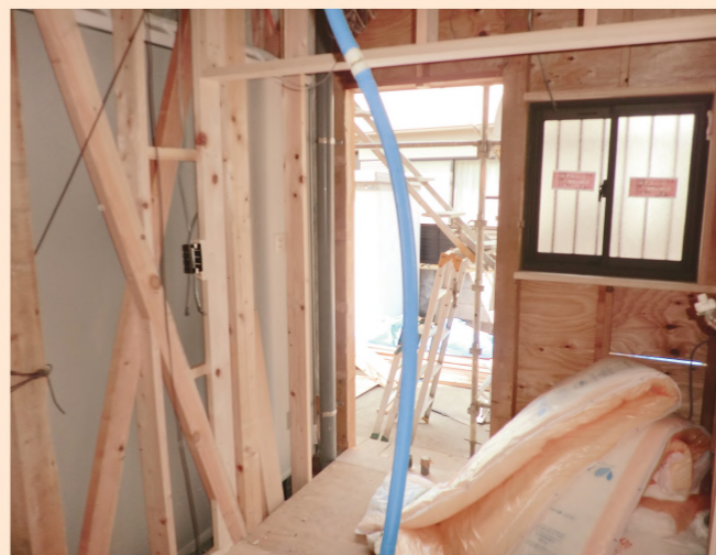
便所、浴室間に新設した筋かい
