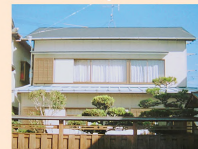
補強後 化粧スレート葺きの軽い屋根に改修しました。
