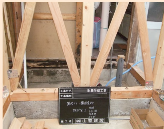
便所、浴室間に新設した筋かい
