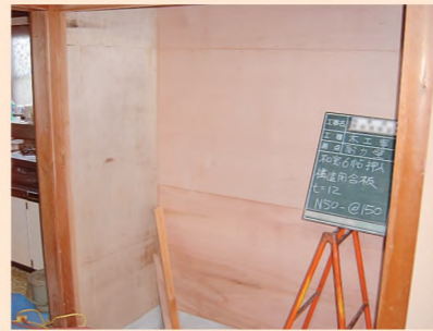
構造用合板による補強 筋かいと構造用合板で補強した箇所です。筋かいだけの補強よりも強い耐力壁にすることができます。
