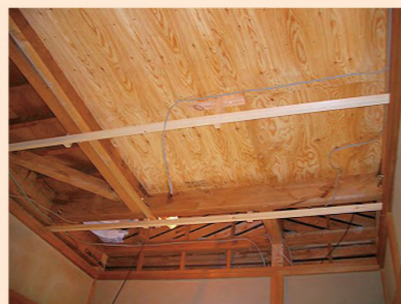
床剛性の確保 2階の床組みを補強することによって、1階に新設した筋かいなどの耐力壁の補強効果が高まります。
