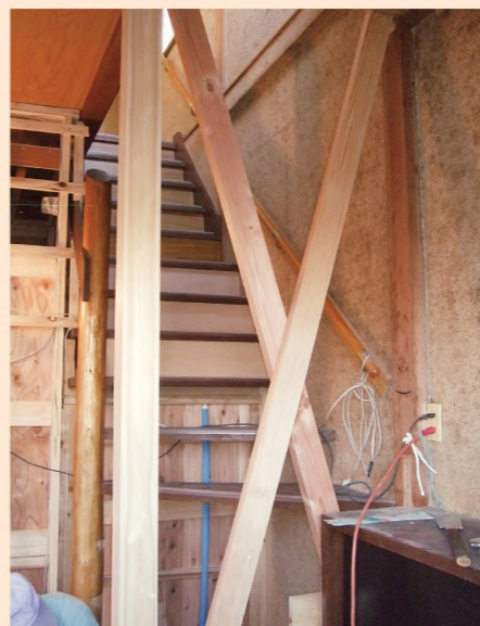
1階玄関ホールに新設した筋かい
