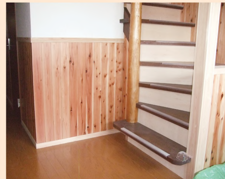
廊下、階段の腰壁に県産材を使用 筋かい設置に伴う内壁復旧工事にあたり、内壁の仕上げ材として県産材を使用しました。
