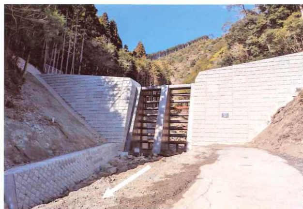
砂防堰堤工事完成 (R7.2)
