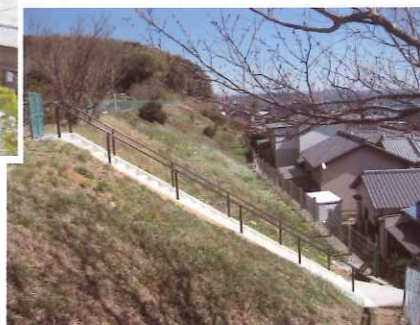
津波浸水区域内の急傾斜地に設置された津波避難兼管理用階段
