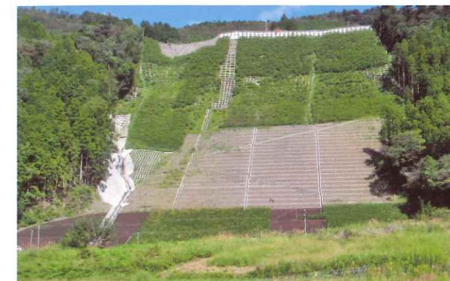
地すべり対策工事完成 (H31.3)
