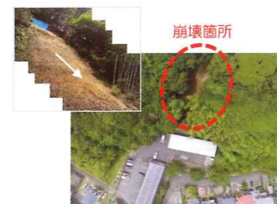
崩壊発生後斜面状況
