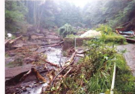
土石流により流木が散乱した河川 (小山町)
