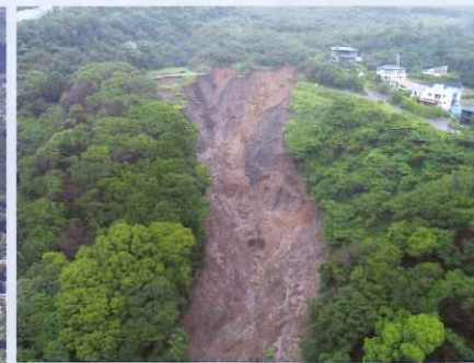
逢初川源頭部の状況
