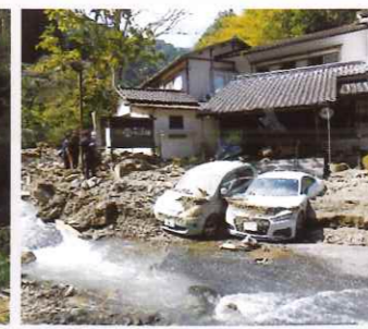
土石流により被災した旅館 (静岡市葵区)
