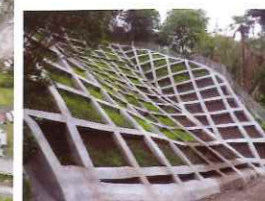
法面工事完成 (R6.6)
