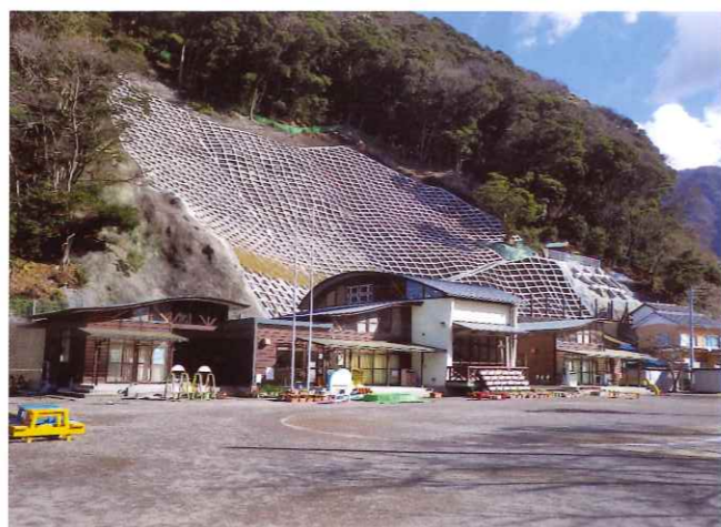
安良里向田No.3急傾斜地 (賀茂郡西伊豆町安良里)
