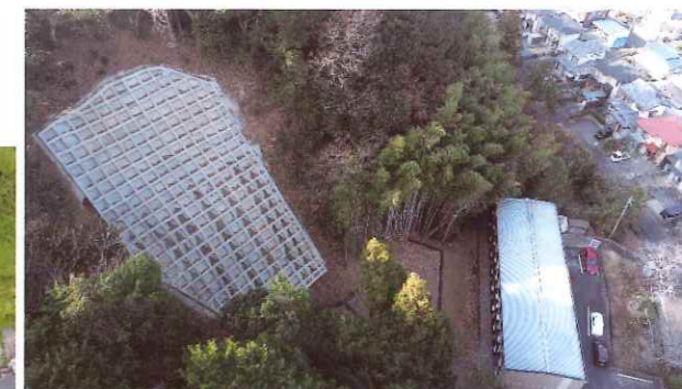
法面工事完成 (R7.1)
