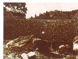
天竜川水系 翁川(浜松市天竜区水窪町) 昭和28年度砂防工事
