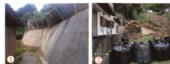
崩壊土砂を捕捉!!
