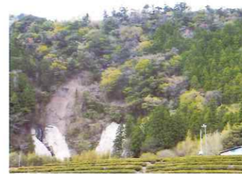
崩壊前斜面状況
