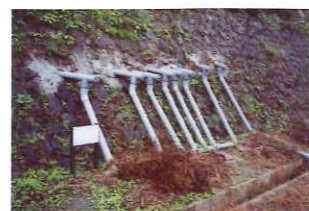
横ボーリング工
