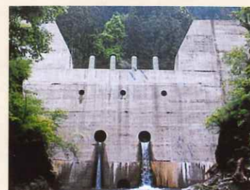
天竜川水系 出馬川(浜松市天竜区佐久間町) 静岡県初めての鋼製スリット堰堤(昭和57年)
