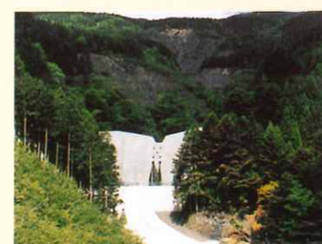
安倍川水系 亀久保沢(静岡市葵区口坂本) 静岡県内最高の砂防堰堤H=26mL=81m(平成元年)
