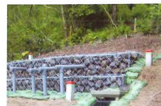
横ボーリング工
