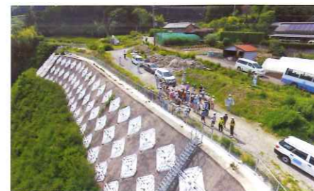
砂防関係工事現場見学会
