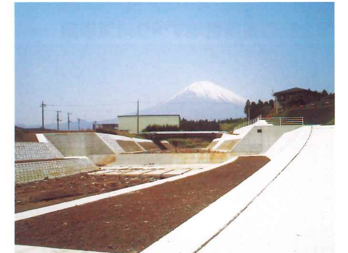
狩野川水系 砂沢川流路工(御殿場市市場)
