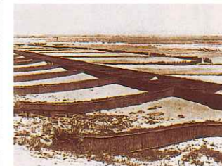
太田川河口右岸(磐田市福田) 昭和14年度河口の海岸飛砂防止対策
