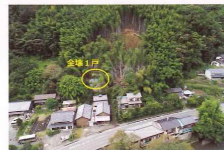
がけ崩れにより人家1戸が全壊 事前の避難により人的被害なし (静岡市清水区)
