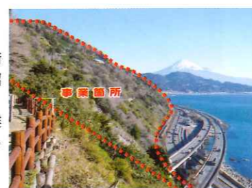
サッタ峠から見た、由比地すべり対策事業区域
