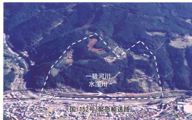
人家と地域の生活道路(国道152号)や鉄道(JR飯田線) を保全する地すべり対策 向島地すべり(浜松市天竜区水窪町地頭方)
