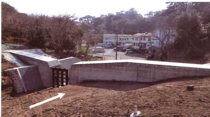
砂防堰堤工事完成 (R6.3)
