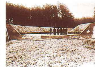
太田川水系 小笠沢川(袋井市豊沢) 昭和8年度農村振興砂防工事
