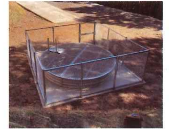
集水井工(ライナープレート)
