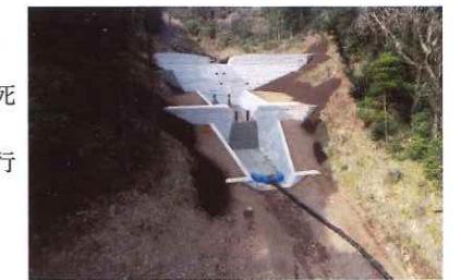
砂防堰堤の施工状況(令和5年2月27日)
