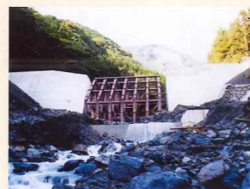
安倍川水系 坂本川(静岡市葵区口坂本) 格子型鋼製砂防堰堤(平成12年)
