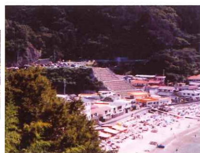
対策工事完成 (危険な斜面の取り除き)
