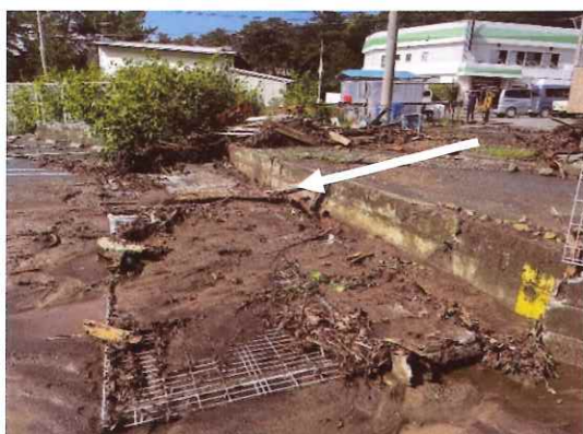
三堂川土砂流出状況
