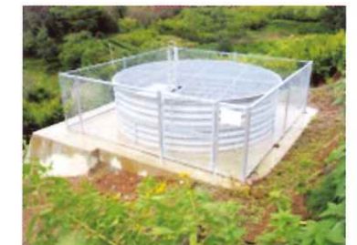
集水井工(ライナープレート)
