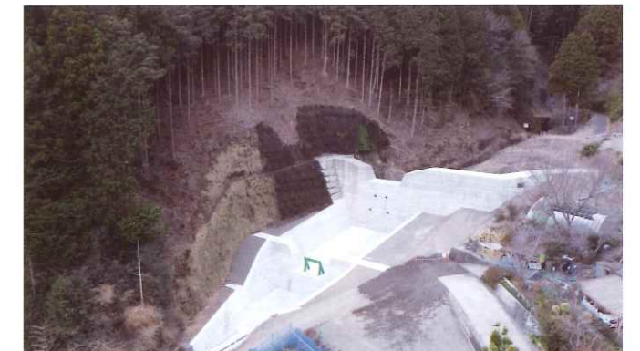
上東木沢砂防堰堤(令和6年3月完成)
