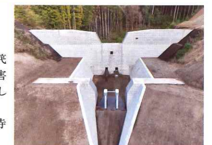
松沢川第1砂防堰堤(令和5年1月完成)
