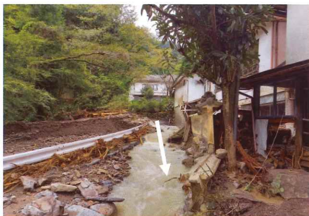
油山川土砂流出状況
