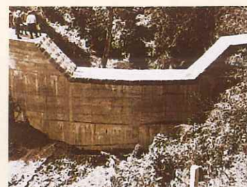
富士川水系 廻沢(富士宮市内房) 静岡県初めてのアーチ式砂防堰堤(昭和28年)
