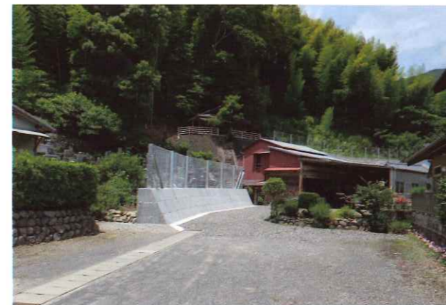
奈良間家ノ上 急傾斜地 (静岡市葵区奈良間)
