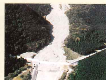
富士川水系 麓川(富士宮市麓) 静岡県内最長の砂防堰堤H=6mL=262m(平成2年)
