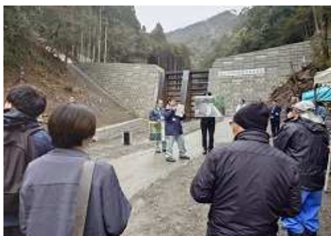
【工事概要の説明】
