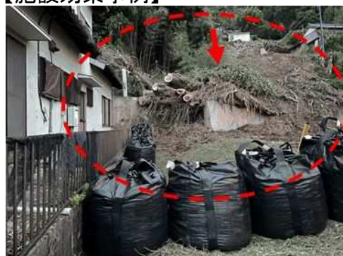
崩壊土砂を擁壁が食い止め被害を防いだ事例(浜松市天竜区渡ヶ島)
