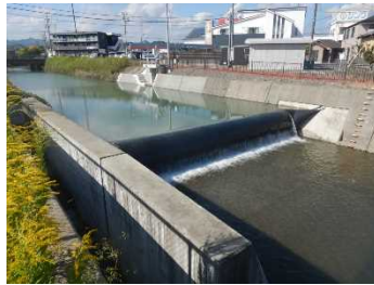
農業水利施設の更新整備（青木頭首工）
