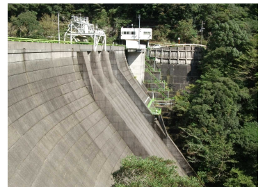
テレメータ設備の更新（大代地区） （大代川農地防災ダム）
