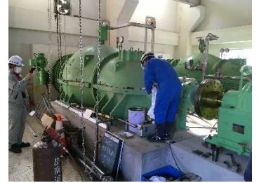
潤滑油採取による機械内部診断（庄内排水機場）
