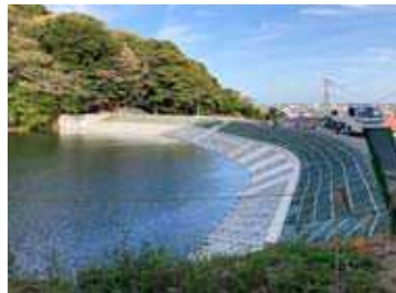
ため池の耐震整備（ため池群坂口谷川地区） （一ノ谷池）
