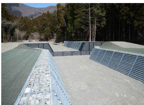
流路を固定し乱流を防止する
