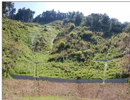
治山事業により復旧した山腹(伊東市)
