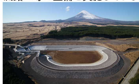
境沢川調節池
