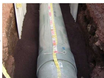
改修工事完了
