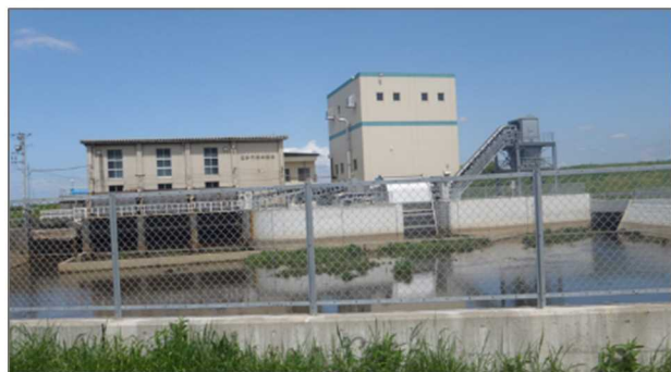
毘沙門排水機場(伊豆の国市)
