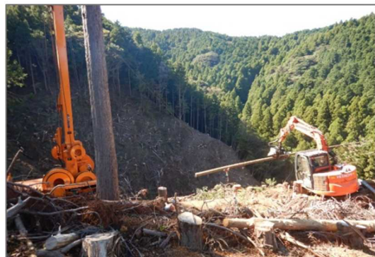
伐採後の丸太を架線集材する様子(沼津市)
