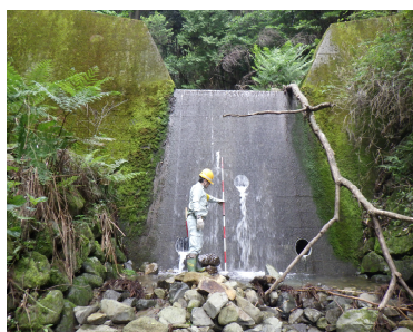
〔既設治山施設の点検状況〕
