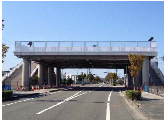
〔吉田町〕歩道橋型の避難タワー
