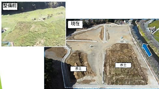
伊豆縦貫道建設発生土(約21万 m^3 )搬入 — 畑面工・道水路工整備
