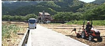
農道整備により機械搬入が容易に(松崎町)
