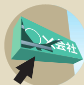
パネル板の破損
