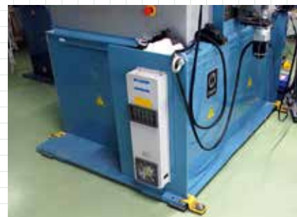
工場内設備を固定し転倒を防止
