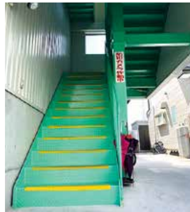
工場屋上への避難階段。地域住民も避難できるよう外階段となっている
