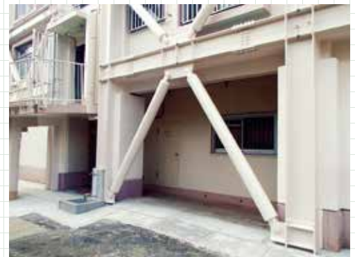
耐震改修工事施工事例
