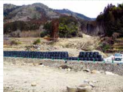
社屋から100m程度上流の山腹崩壊箇所。ここから土砂・流木が下流に流出
