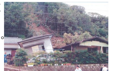
写真 | 中部地方整備局沼津河川国道事務所
