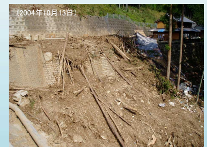
崩土が直撃した人家跡
