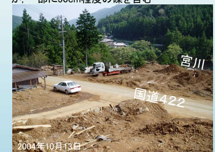
崩壊上部から流下跡を見る
