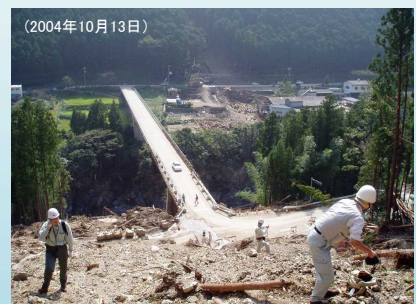
崩壊源頭部から下流を見る
