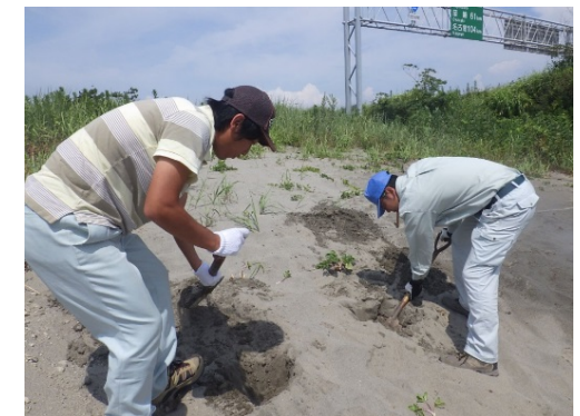
砂法面に植生を復元する方法を検討 (工事地内のハマボウフウを移植)
