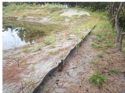
畦波シート、立入防止ロープ
