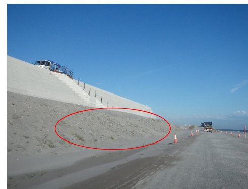
舞阪地区では防潮堤を砂で被覆
