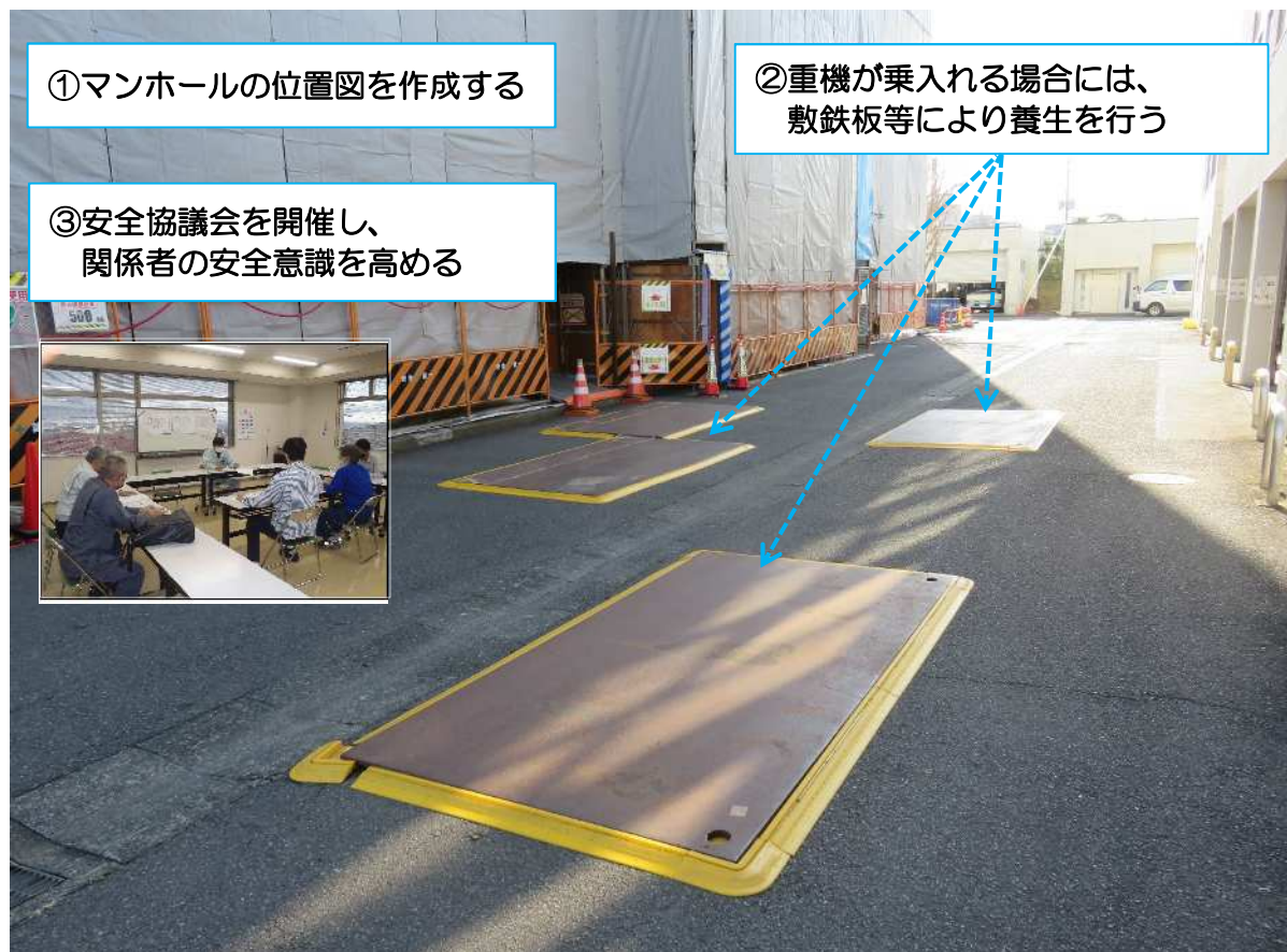
安全対策後の現場状況
