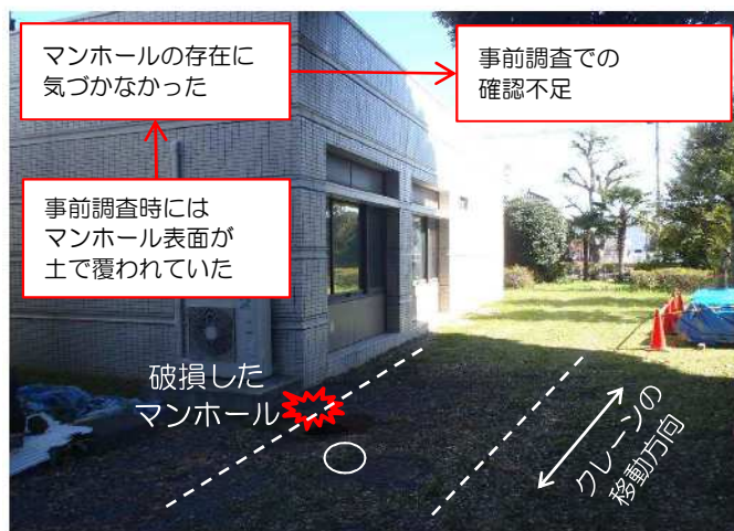
安全対策前の現場状況
