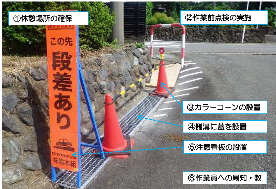
安全対策後の現場状況
