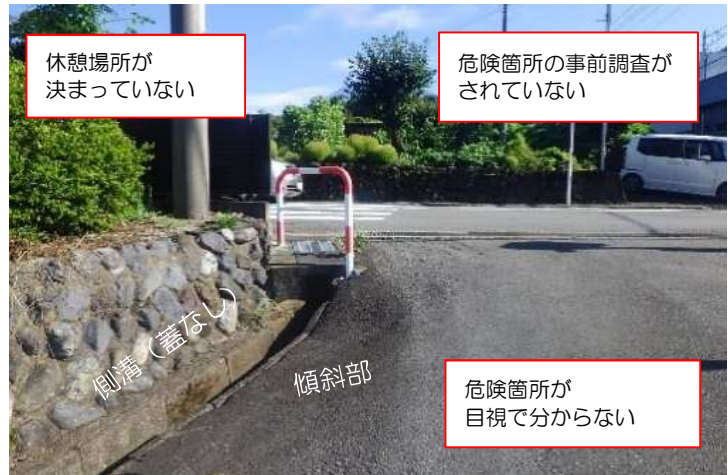
安全対策前の現場状況
