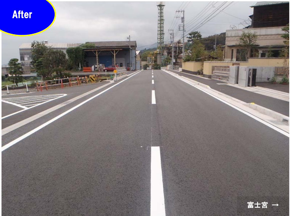
工事完成後 (H28. 10. 5 撮影)
