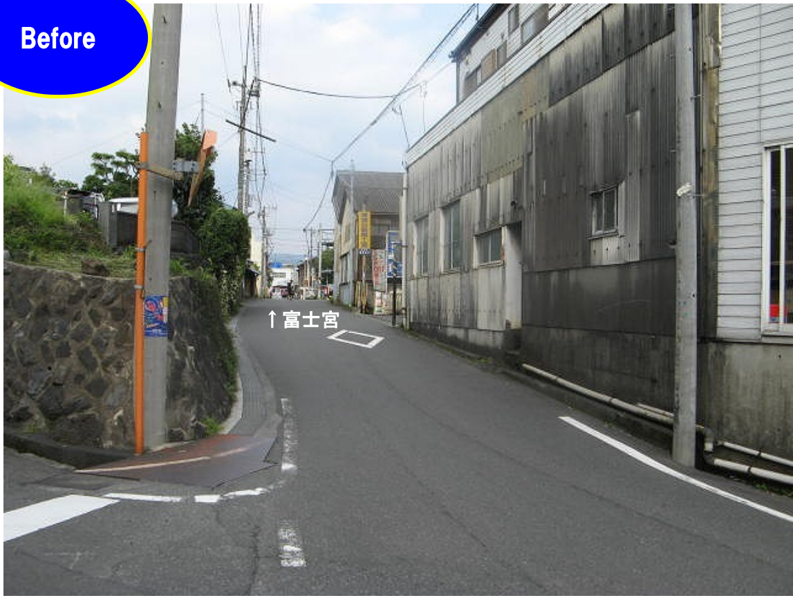
工事着手前 (H24. 9. 12 撮影)
