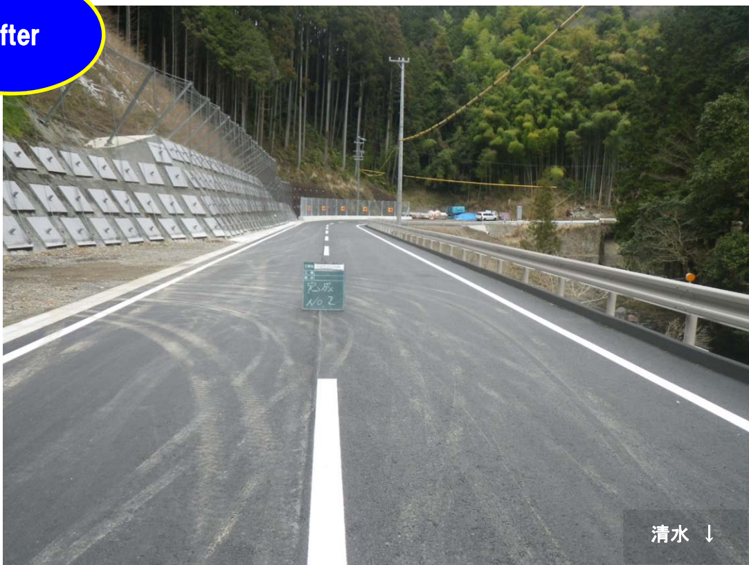
工事完成後（H28. 3. 13 撮影）
