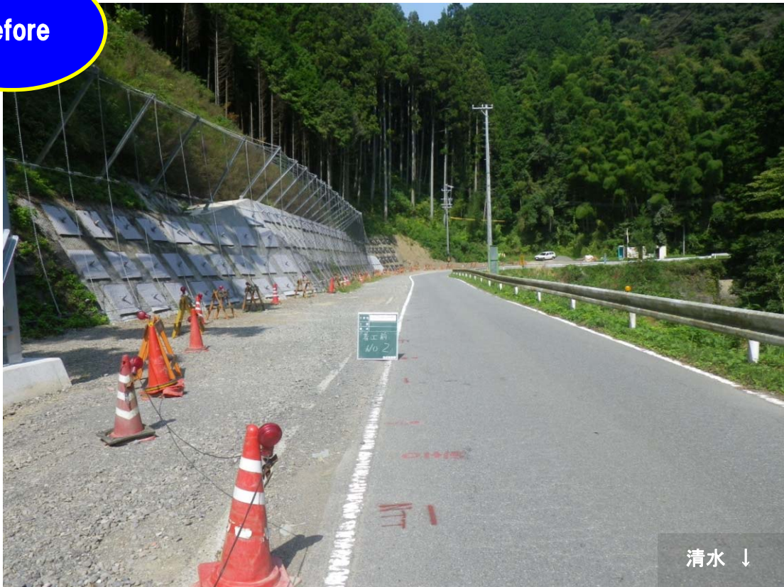
工事着手前（H27. 9. 29 撮影）
