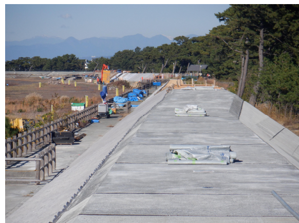
沼津牛臥海岸 堤防嵩上げ整備状況
