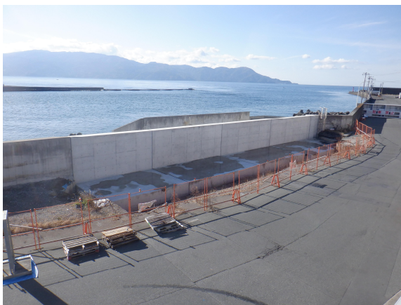
沼津港海岸 胸壁整備状況
