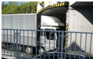
平成19年8月10日 大型車破損事故
