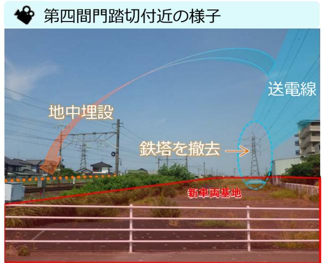
現況 □ 鉄塔 — 送電線 移設後 □ 鉄塔 — 送電線 ..... 送電線 (地中) ■ 事業範囲
