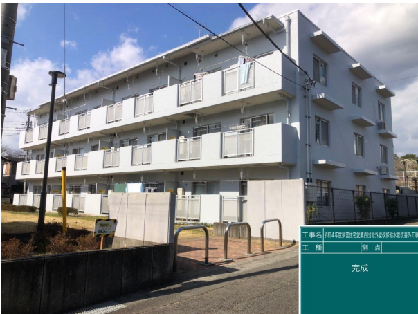
県営愛鷹西団地 南面 完成(令和5年3月)
