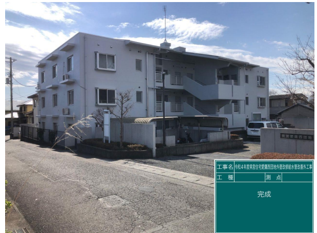
県営愛鷹西団地 北面 完成(令和5年3月)
